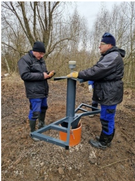
Usazení a měřičské zaměření nosné konstrukce prototypu koutového odražeče
