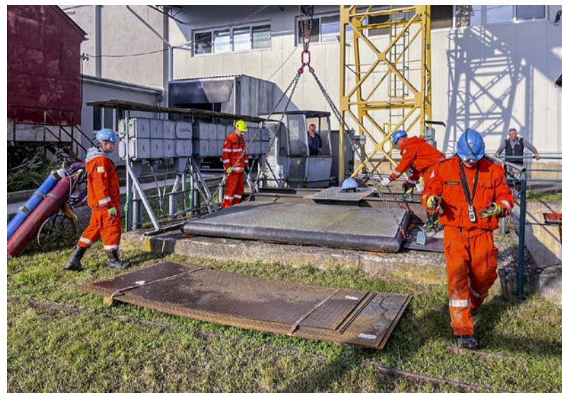
Záchranáři při výměně ocelových podlah
