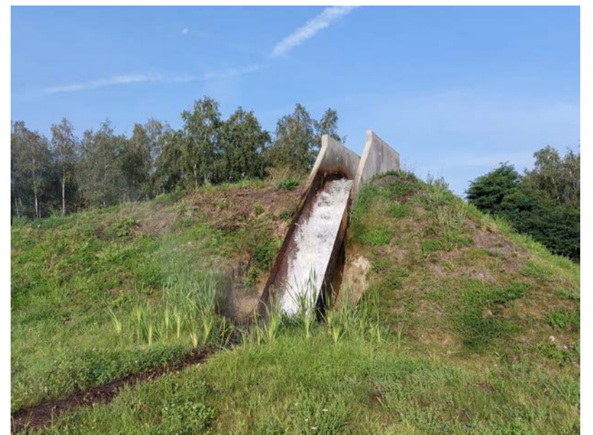
Přivadní (provzdušňovací) objekt do Biotechnologického systému pro čištění důlních vod z jámy MR1
