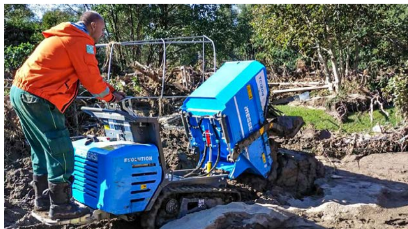
Odstraňování škod v obci Karlovice
