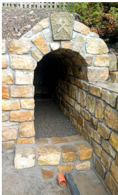
Vstupní portál před dokončením
