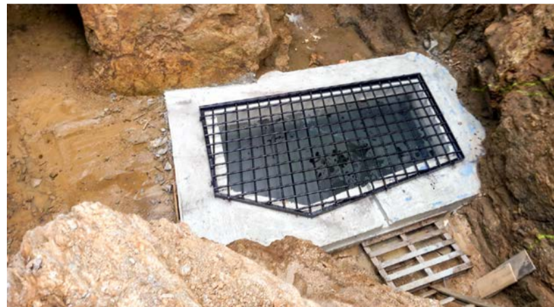
Zabezpečená ohlubeň jámy
