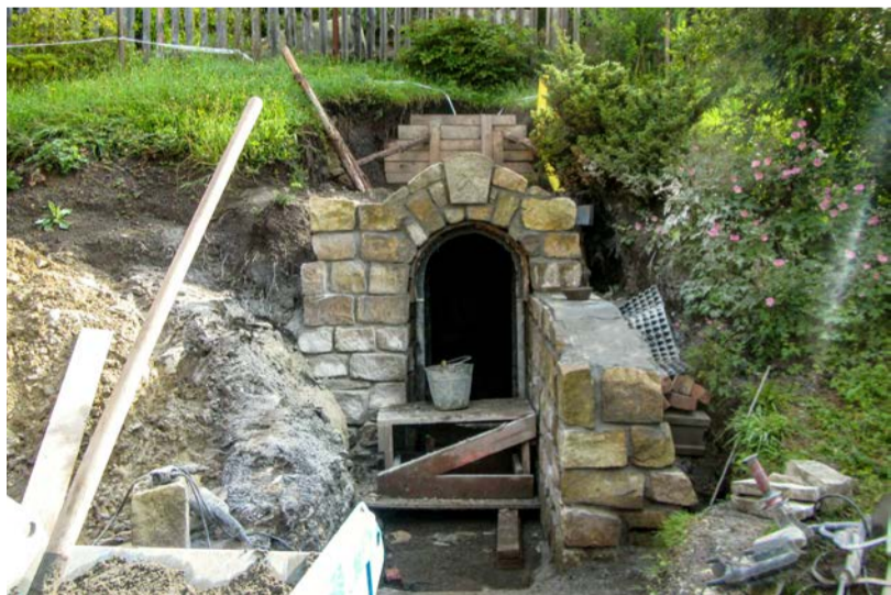
Průběh prací na vstupním portálu
