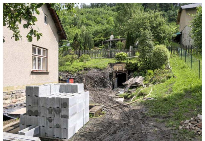
Práce na odvodnění objektu
