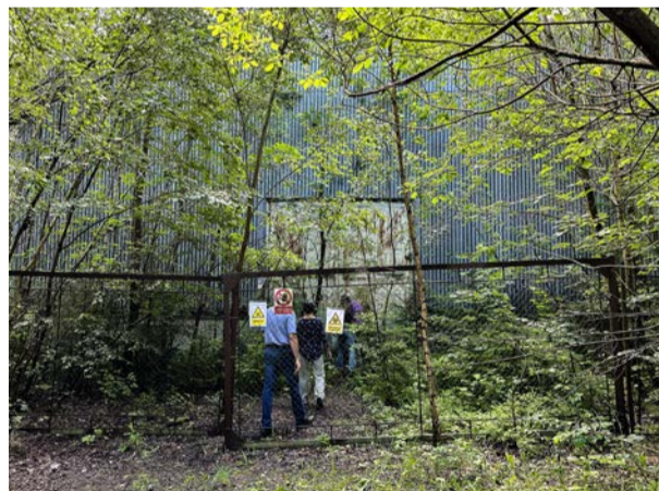
Hala s kadmiovými odpady
