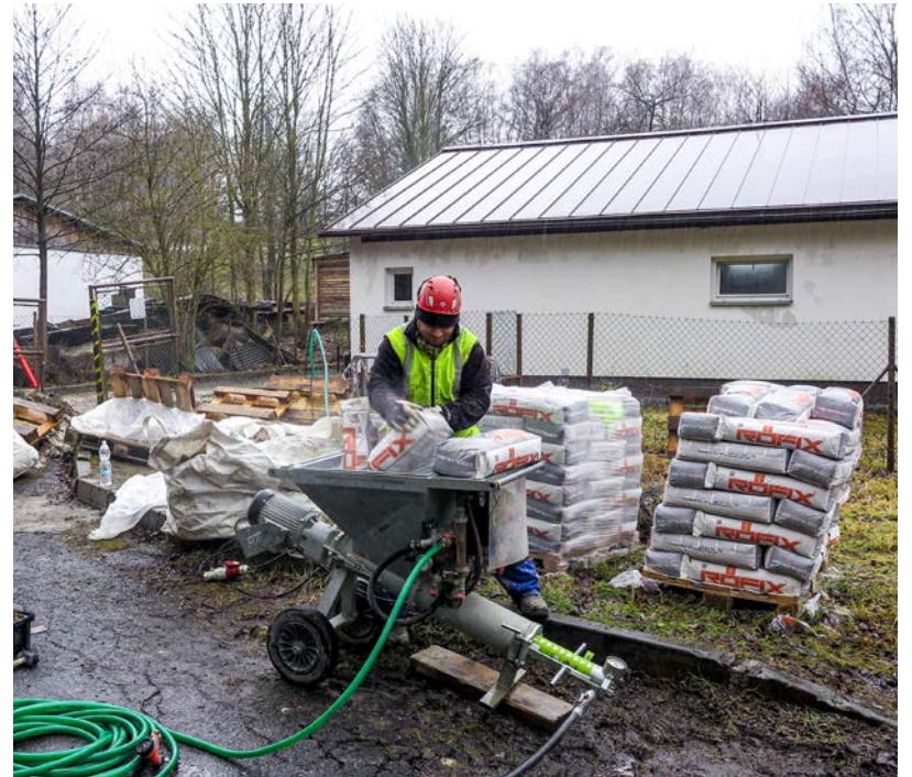
Probíhající práce na zabezpečení propadu
