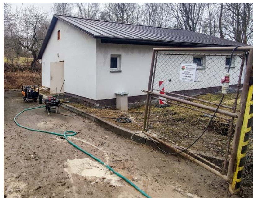
Čistírna odpadních vod ve Městě Krásno
