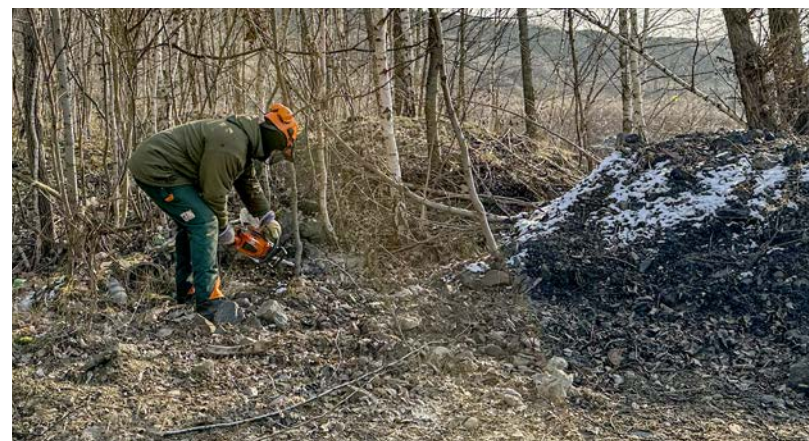
Přípravné práce pro stavbu sarkofágu na haldě Heřmanice
