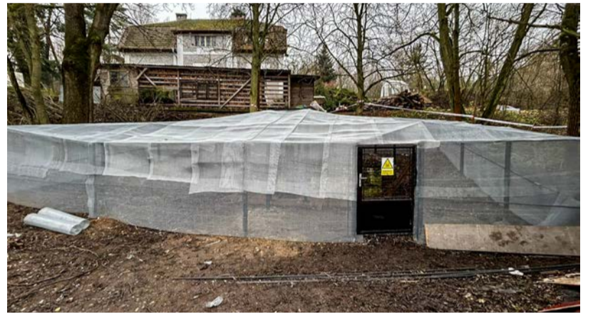
Zasítování ocelové konstrukce – konečný stav nového oplocení
