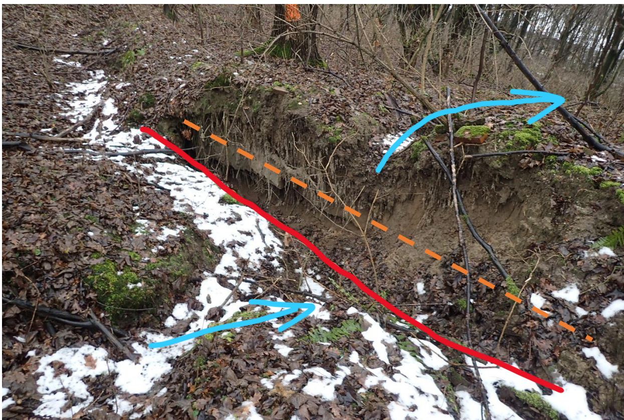
Obrázek č. 5 – SD 3, místo číslo 2 – křížení odvodňovací rýhy a podélné trhliny, stav v roce 2024
