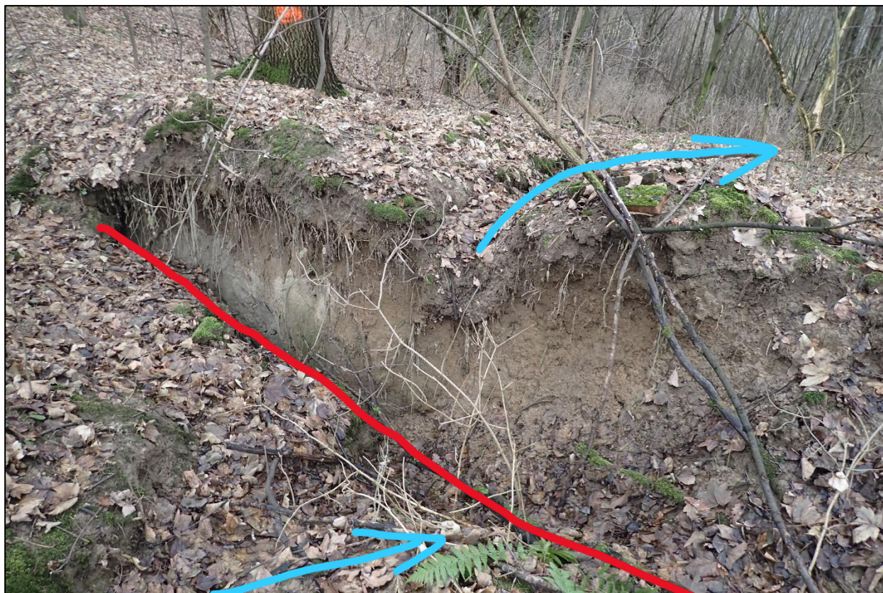
Obrázek č. 5 – SD 3, místo číslo 2 – křížení odvodňovací rýhy a podélné trhliny, stav v roce 2024
