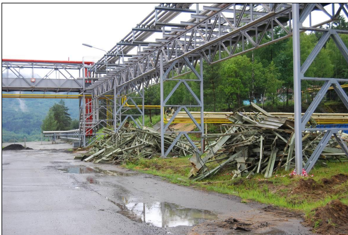
Obrázky č. P2-5, 6: Likvidace trubního mostu NDS 10
