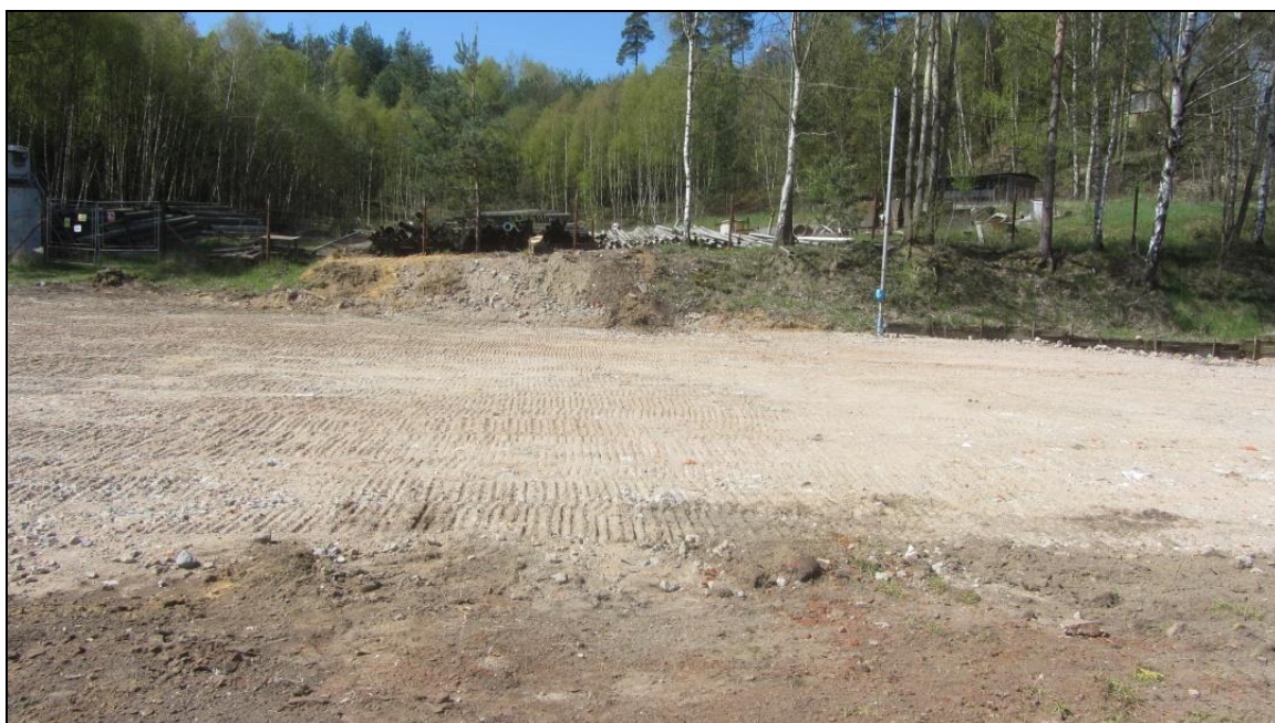
Obrázky č. P2-3, 4: Likvidace stavebních objektů NDS 6
