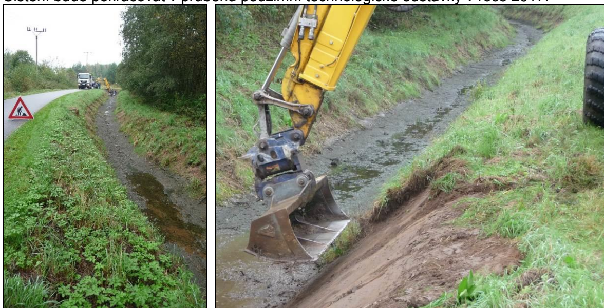
Obrázky č. 1-6, 7: Postup čištění koryta obtokového kanálu
