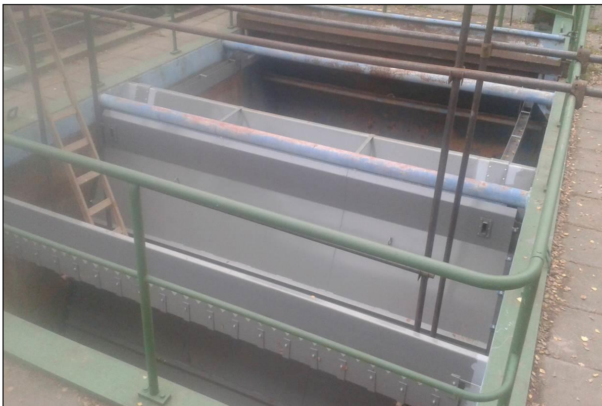
Obrázek č. 1-2: Oprava ČOV CHÚ
