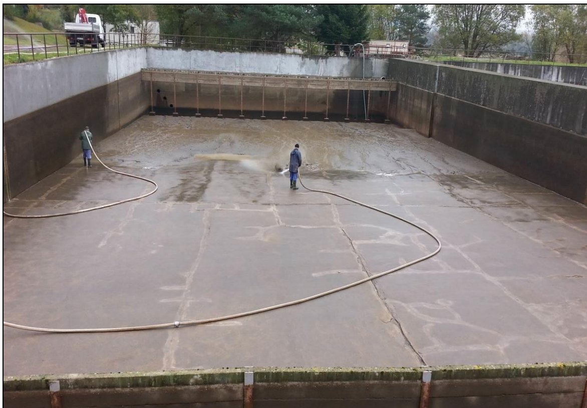
Obrázek č. 1-3: Čištění RN CHÚ
