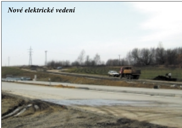
Nové elektrické vedení
