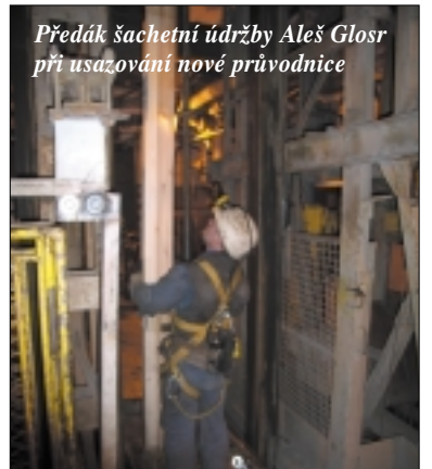
Detail nové rámové výztuže v jámě R1
