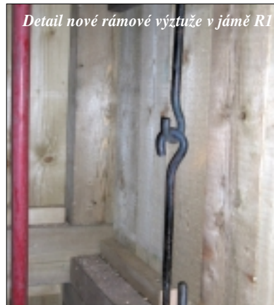
Zabudované nové rámy v jámě R1
