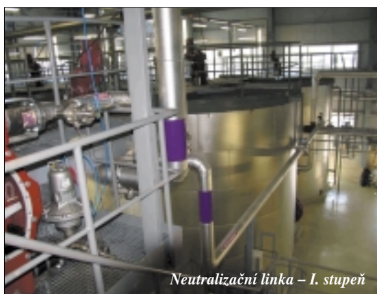
Dávkovací čerpadlo vápenného mléka do reaktoru I. stupně
