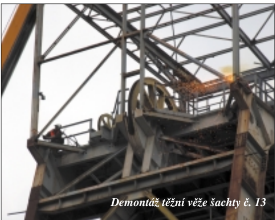
Demontáž těžní věže
