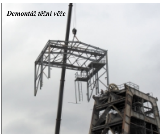
Demontáž těžní věže šachty č. 13
