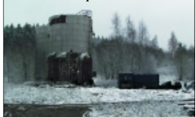
Ocelové nádrže před likvidací
