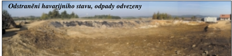
Odstranění havarijního stavu, odpady odvezeny
