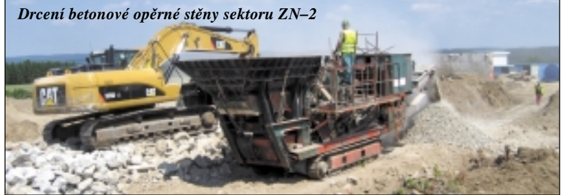
Drcení betonové opěrné stěny sektoru ZN-2
