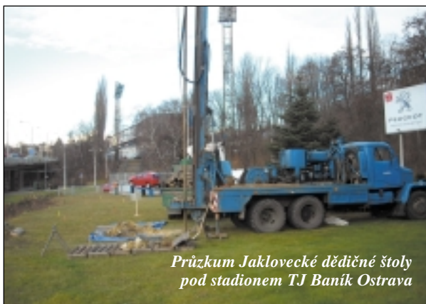
Odsávací zkouška na odplynovacím vrtu VM-OV č. 17
