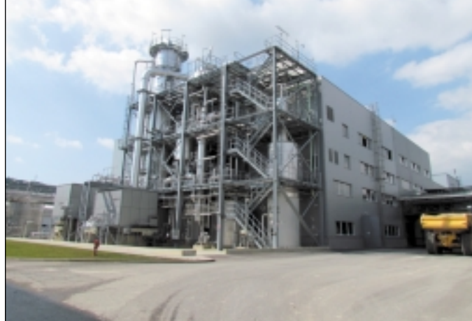
Vpředu stripování amoniaku, navazuje hala filtrace
