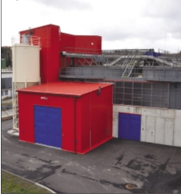
Objekt sedimentačních nádrží
